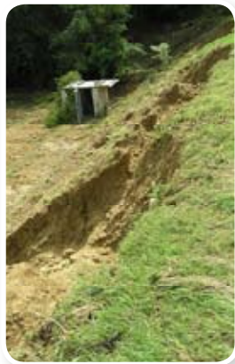
Glissement de terrain
