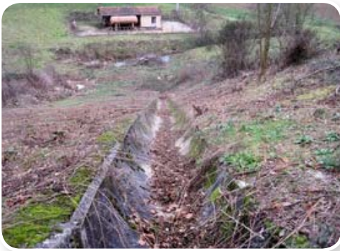
Entretien des abords du coursier (broyage de la végétation arbustive)
