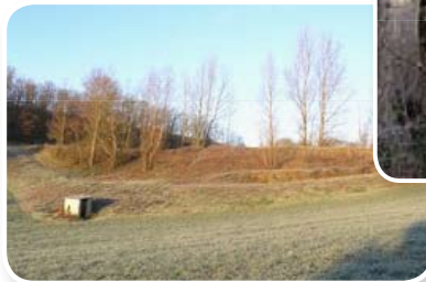
Arbres sur le parement
