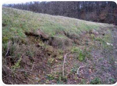
Antibatillage dégradé
