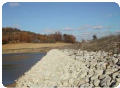
Antibatillage en bon état et absence d'érosion
