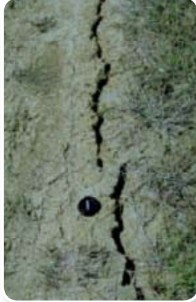
Fissures et mal enherbé
