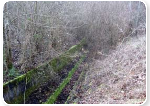
Coursier non entretenu avec arbustes
